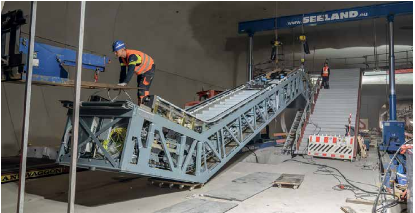
Fahrtreppen, nicht Rolltreppen: Mit ihnen wird der neue Stuttgarter Hauptbahnhof barrierefrei.
