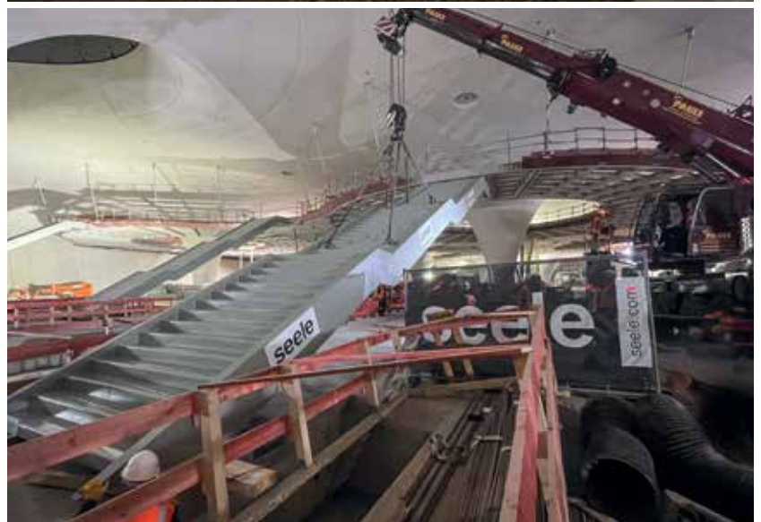
Der Einbau der Treppen zu den Bahnsteigen erfordert Millimeterarbeit – beim Rangieren des Tiefladers, beim Abladen, und wenn eine der Treppen am Kranhaken hängt.
