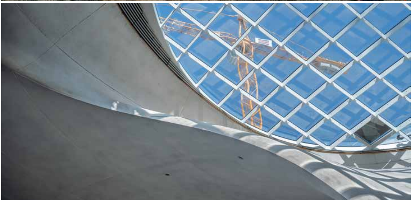
Markant und einzigartig sind nicht nur die Kelchstützen und ihre Lichtaugen, sondern auch die Gitterschalen über den Hauptzugängen zur Gleishalle wie am Südkopf des Durchgangsbahnhofs (oben).
